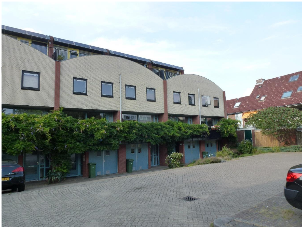
Nieuwbouw aan de Moeflonstraat met inpandige lager gelegen garages en zonnecollectoren
